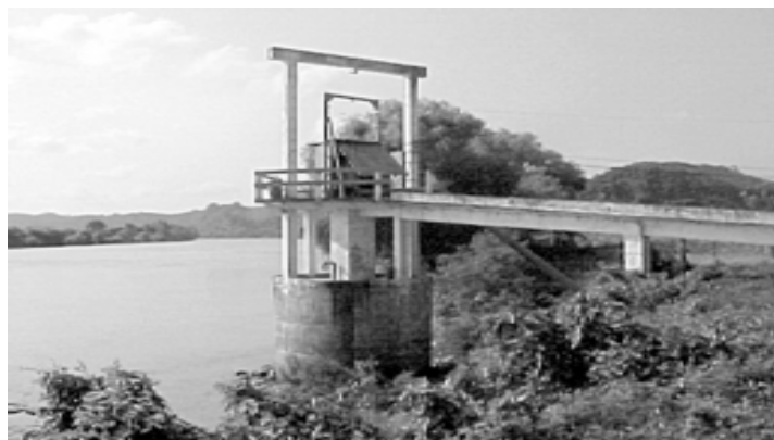
Figura 35 Estación hidrométrica en el río Tecolutla, Veracruz
