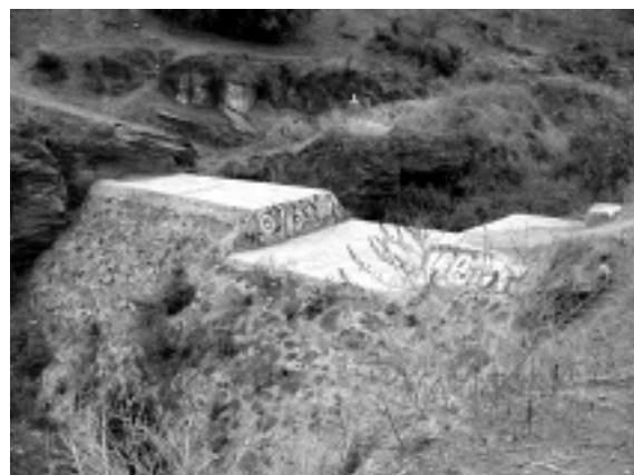
Fig. 38. Presa reguladora de avenidas (rompe-picos).
