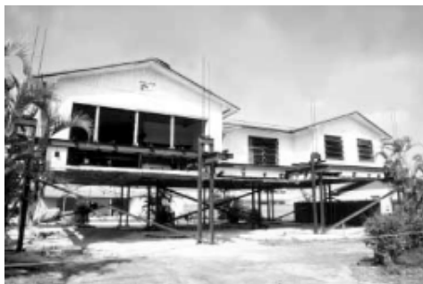
b) Baja Vulnerabilidad. El nivel del piso en la casa es más alto que el de la calle.
