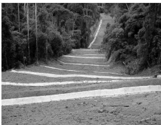
Fig. 39. Estabilización de pendientes.
