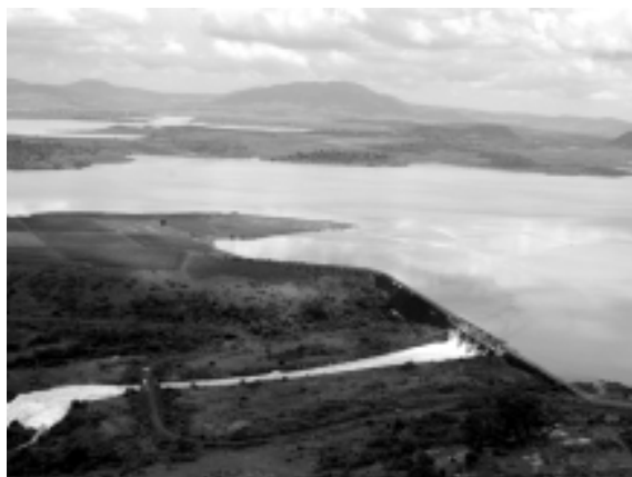
Fig. 37. Presa de almacenamiento.
