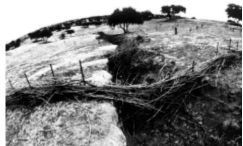
Figura 52. Ensayo de diferentes hidrotecnias para el control de torrentes y cárcavas de gran longitud aprovechando materiales del propio terreno. www.fundacionglobalnature.org/sevilla/sevilero.html
