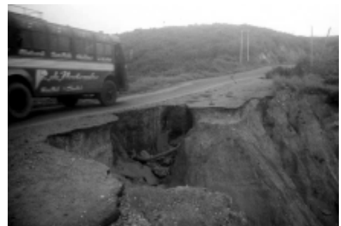
Figura 46. Deslave en una carretera de Nicaragua kyapa.tripod.com/elniinoycarreteras
