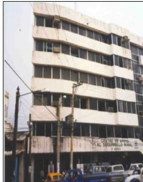
Figura 3.11 Edificio Roberto Posadas. El Puesto Central de Registro PCR-1 de la CNA se localiza en el 4º piso
