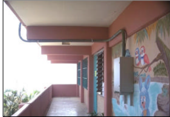
Figura 3.4 Instalación del gabinete en la escuela de la estación La Mira, MA-02
