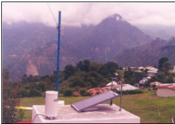
Figura 6.4 Pluviómetro, celda solar y antena de radio sobre el techo del, centro de salud, estación Agua Caliente AC-03
