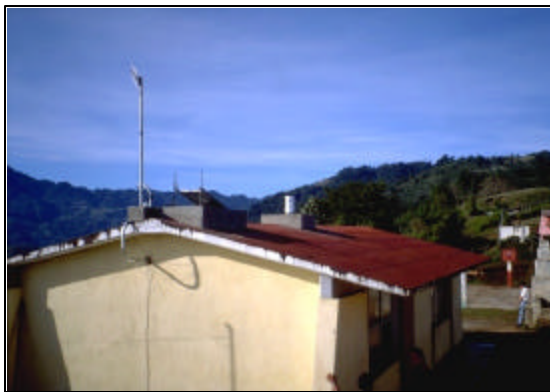
Figura 5.2 Pluviómetro, celda solar y antena de radio instalados en la azotea de un salón de clases, estación Ignacio Allende IA-01
