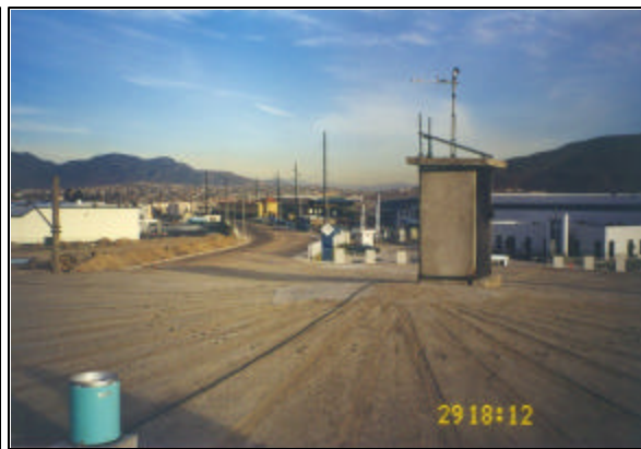
Figura 4.4 Caseta, panel solar, pluviómetro y antena. Estación El Lago, LA-03
