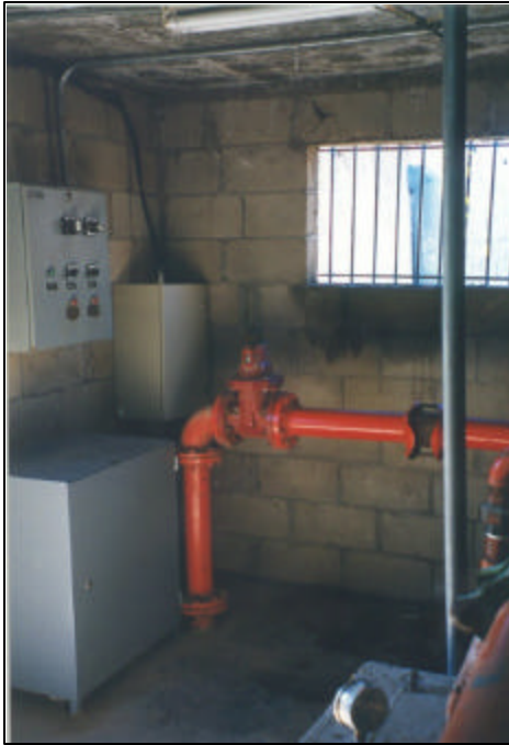
Figura 4.14 Gabinete con el equipo de registro y comunicaciones dentro de la caseta de control de bombeo. Estación Sánchez Taboada
