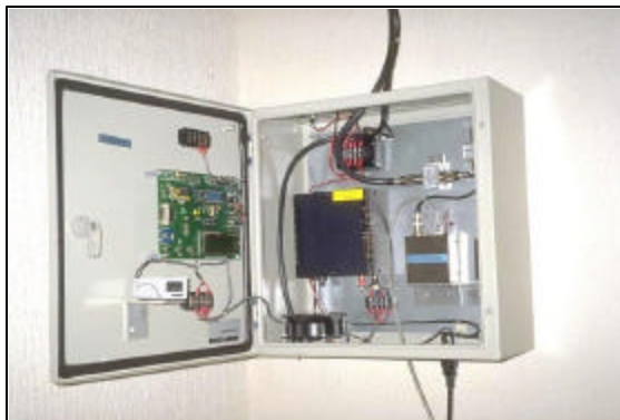
Figura 5.11 Palacio Municipal. Equipo de comunicaciones en el Puesto Central de Registro PCR-1 y estación Palacio Municipal PM-05
