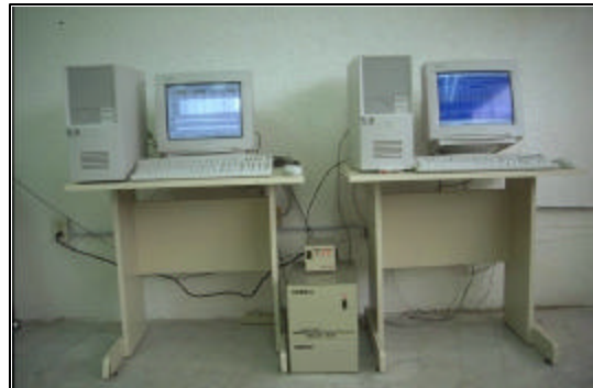
Figura 3.14 Vista de las dos computadoras Telemetría e Hidráulica en el PCR-1
