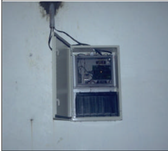
Figura 5.5 Vista interior del gabinete con los módulos de control y comunicación. Estación Las Cruces
