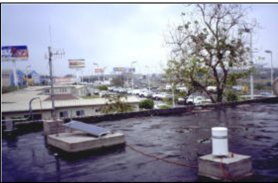
Figura 7.8 Pluviómetro, celda solar y antena, estación Fierro, FE-04
