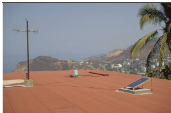
Figura 3.2 Pluviómetro, celda solar y antena de radio instalados en la azotea de la estación La Mira, MA-02
