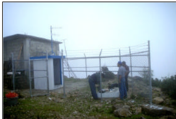
Figura 5.12 Vista de la estación repetidora en Mozotal
