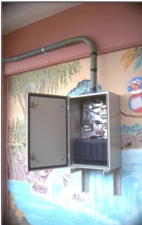
Figura 3.5 Vista interior del gabinete con los módulos de control y comunicación. Estación La Mira
