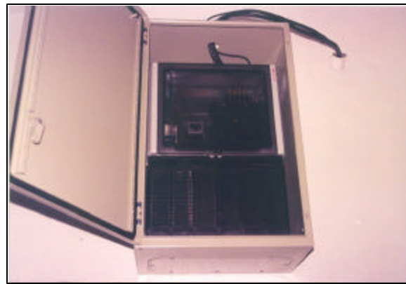
Figura 6.5 Vista interior del gabinete con los módulos de control y comunicación. Estación Agua Caliente
