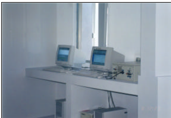
Figura 4.23 Puesto Central de Registro PCR-1 en las nuevas instalaciones de la Dirección Estatal de Protección Civil
