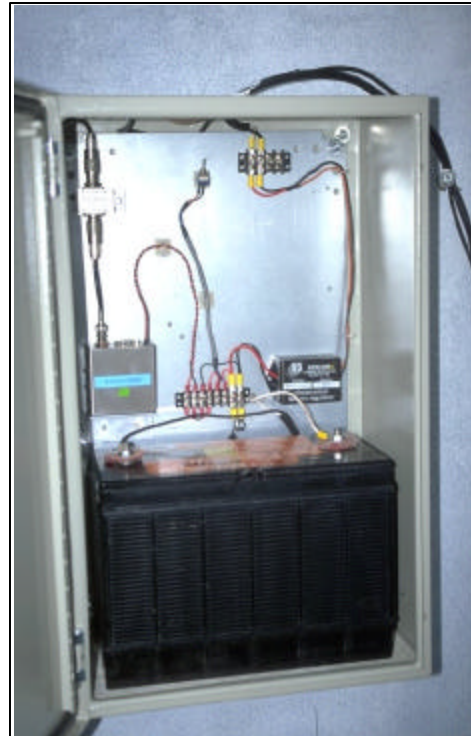
Figura 5.14 Vista del interior del gabinete de la estación repetidora Mozotal
