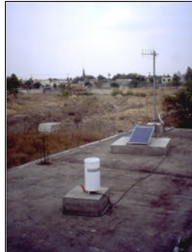
Figura 7.7 Pluviómetro, celda solar y antena de radio, estación Ciudad Universitaria, CU-03
