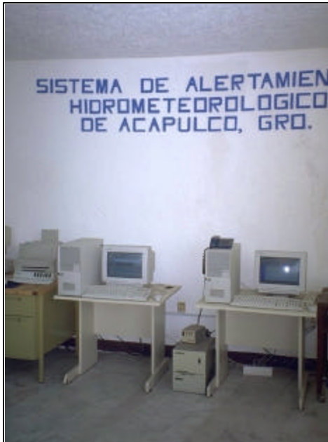
Figura 3.12 Vista del Puesto Central de Registro PCR-1 en las oficinas de la CNA
