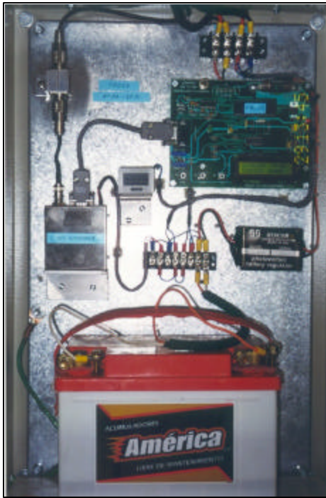
Figura 4.10 Detalle del interior del gabinete con los módulos de control y comunicación
