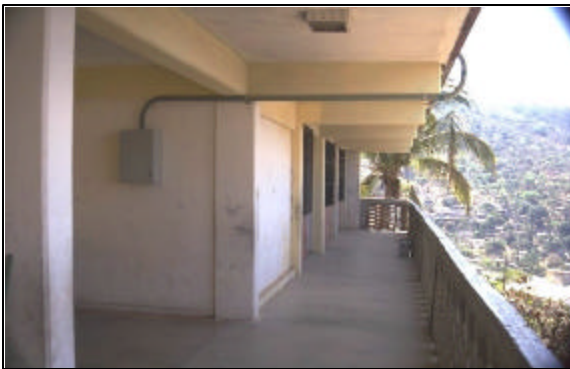
Figura 3.8 Instalación del gabinete en la escuela Nicolás Bravo, estación La Garita, GS-04
