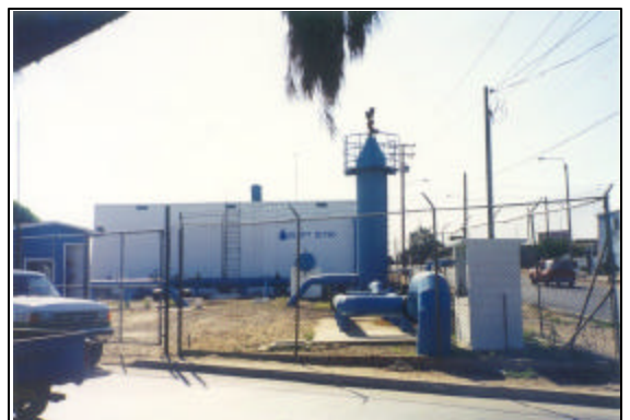
Figura 4.18 Tanque de agua donde está la estación Miramar MA-09
