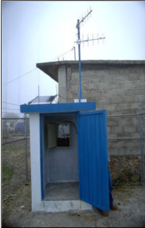
Figura 5.13 Estación repetidora Mozotal
