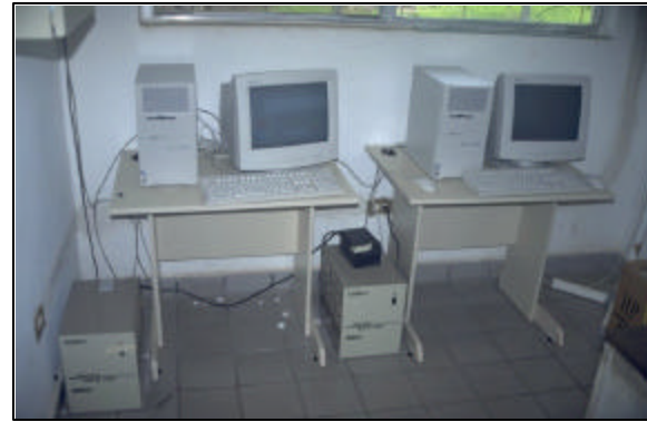
Figura 6.15 Equipo de cómputo en el Puesto Central de Registro PCR-2
