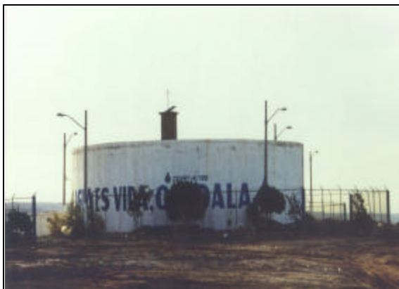
Figura 4.3 Caseta construida sobre tanque de almacenamiento de agua. Estación 3 "El Lago", LA-03
