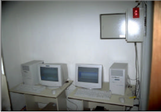
Figura 6.12 Vista del Puesto Central de Registro PCR-1 en las oficinas de la Unidad Municipal de Protección Civil de Tapachula
