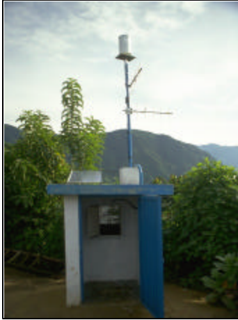
Figura 6.6 Caseta de concreto que contiene en su totalidad a la estación La Soledad SO-04
