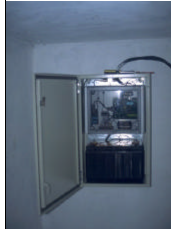
Figura 6.7 Vista interior del gabinete con los módulos de control y comunicación, estación La Soledad
