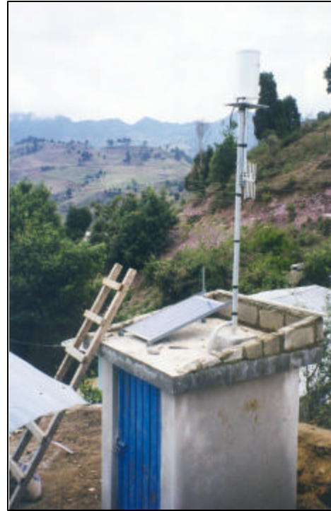
Figura 5.6 Vista de la caseta que contiene a la estación La Mina MI-04
