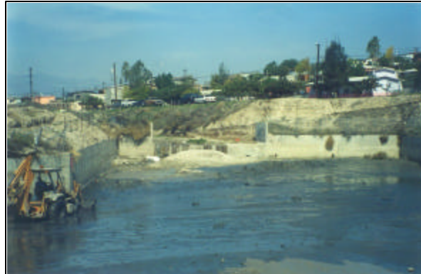
Figura 4.30 Canal de llamada del desarenador en el cauce del arroyo "El Florido"
