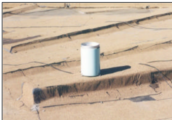
Figura 4.24 Pluviómetro de la estación Protección Civil Estatal PC-01
