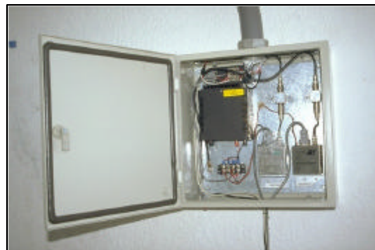
Figura 3.15 Vista interior del gabinete con los módulos de control y comunicación en el Puesto Central de Registro PCR-1
