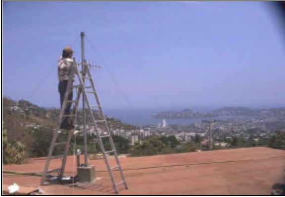
Figura 3.3 Instalación y alineación de la antena de radio dirigida hacia el Puesto Central de Registro de la CNA
