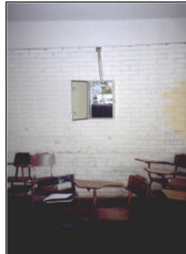
Figura 7.3 Gabinete con el equipo electrónico de registro y comunicaciones dentro de la estación San Martín
