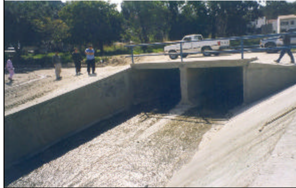
Figura 4.28 Canal de llamada del desarenador #1 en el cauce del arroyo "Aguaje de la Tuna"
