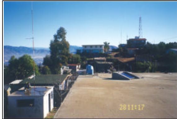
Figura 4.11 Caseta de control de bombeo, tanque de almacenamiento de agua, celda solar y antena. Estación Sánchez Taboada ST-06
