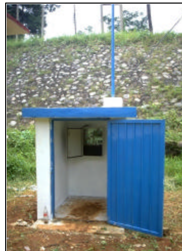
Figura 6.11 Caseta de concreto donde está alojado el equipo de registro y comunicaciones, estación La Presa
