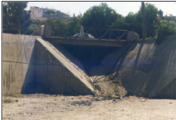
Figura 4.29 Entrada al canal desarenador del arroyo "Sánchez Taboada"
