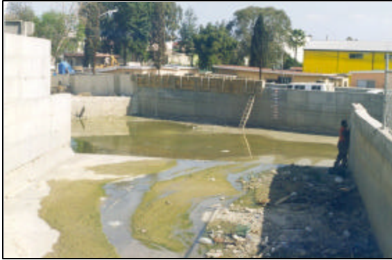
Figura 4.27 Canal de llamada del desarenador #1 en el cauce del arroyo "Aguaje de la Tuna"
