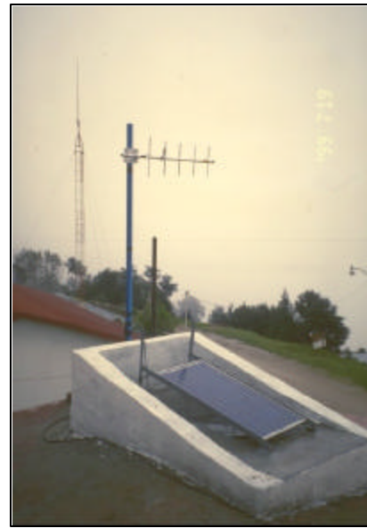
Figura 6.3 Celda solar y antena de radio, estación Ignacio Zaragoza
