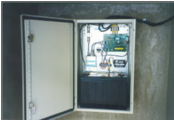
Figura 5.7 Gabinete con los equipos de control y comunicaciones, La Mina
