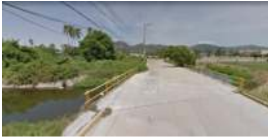
Canal localizado en el Sector VI que se incorpora al Sector V
