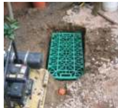
Ejemplo de Pozos y zanjas de infiltración
